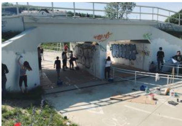
Podchod pred úpravou
